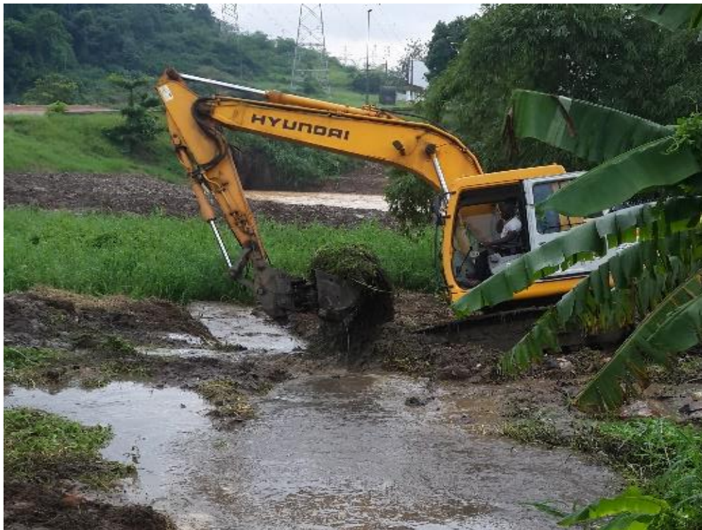
Figure 01 : Ouverture de l'exutoire en lagune de la rivière Banco
