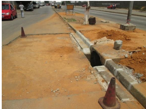
Figure 08 : Travaux de réparation d'un effondrement de conduite
