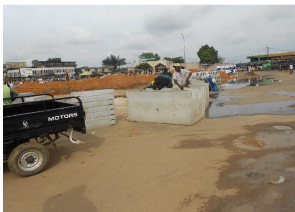
Figure 05 : Fouille et fournitures d'ouvrages
