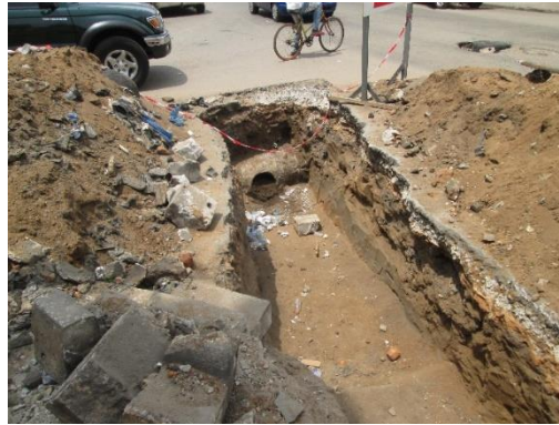
Figure 06 : Fouille pour pose de canalisation d'assainissement
