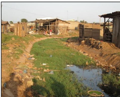
Figure 14 : Canal primaire ensablé
