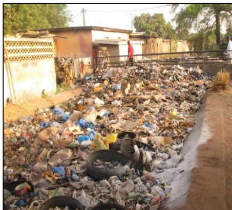
Figure 10: Canal primaire obstrué de déchets ménagers
