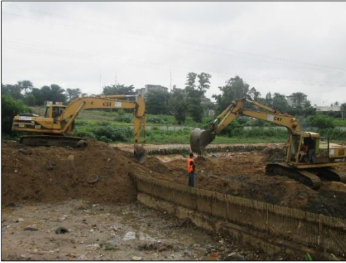
Figure 03 : Curage du bassin de retenue de Fraternité Matin
