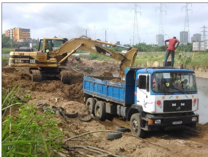
Figure 02 : Curage du bassin de retenue du lycée technique
