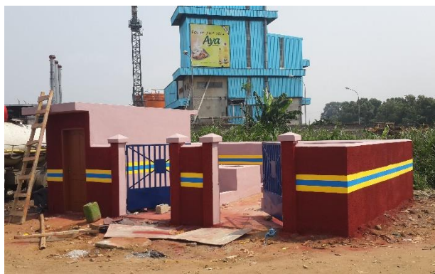
Figure 17 : Poste de dépotage de Yopougon
