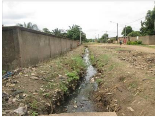
Figure 07 : Canal en terre à bétonner
