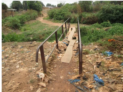
Figure 11 : Ouvrage de franchissement de fortune sur la rivière
