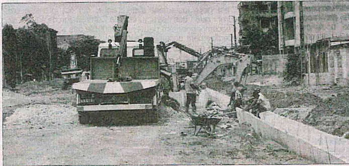
Après seulement deux mois de travaux...
