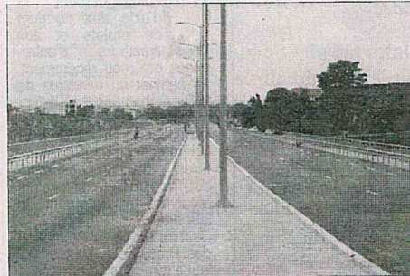
La voie Jacques Prévert-Mpouto fraîchement achevée a fière allure.
