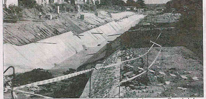
Le principal drain en construction entre le carrefour Kimi et la lagune au village de Lokoua (Yopougon) est en finition. (PHOTOS: PORO DAGNOGO)
